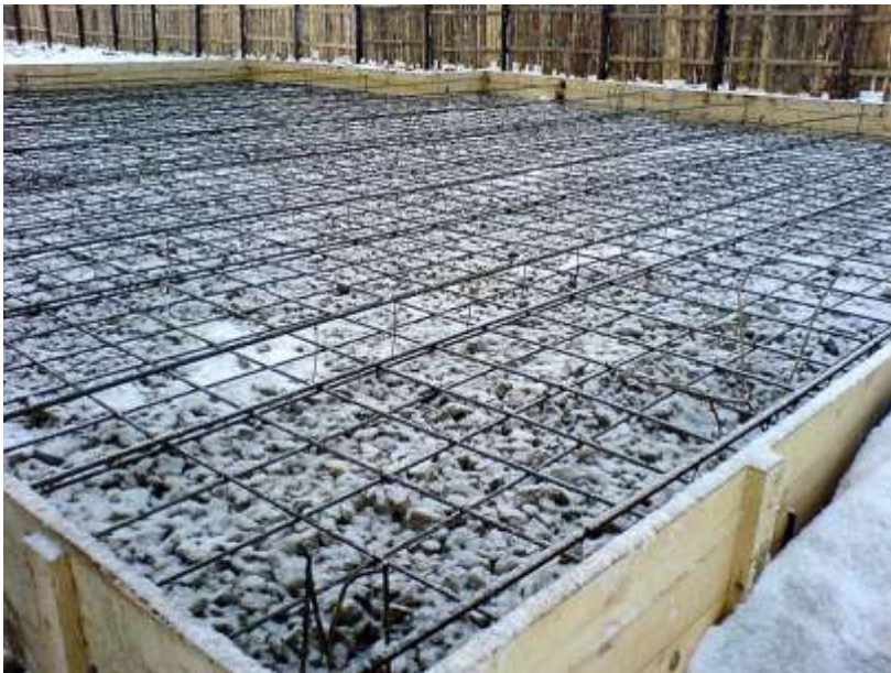
Плитный «плавающий» фундамент
